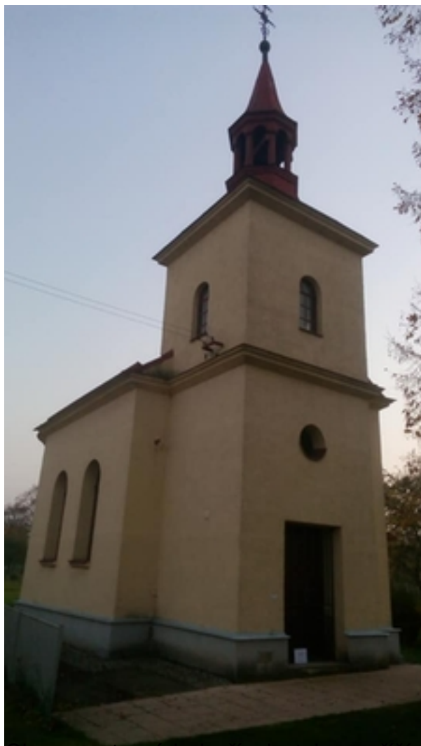
Obnova vstupních dveří a instalace mříží v kapli.
